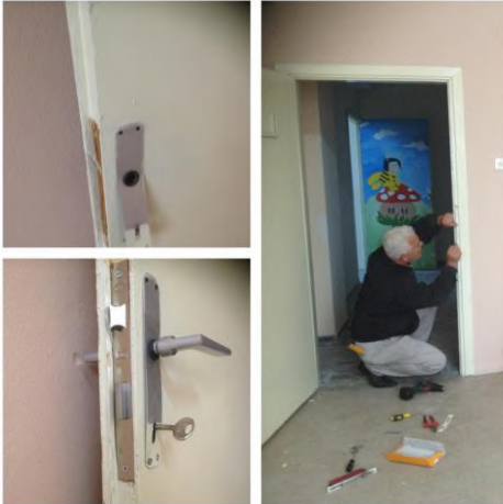
Fotoğraf 4- Atölye kapısının tamir edilmesi
