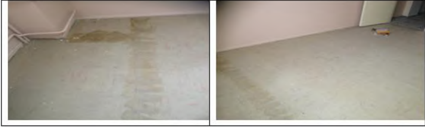
Fotoğraf 3- Atölye zeminine mineflo kaplanmadan önceki hali 13 Kasım 2013
